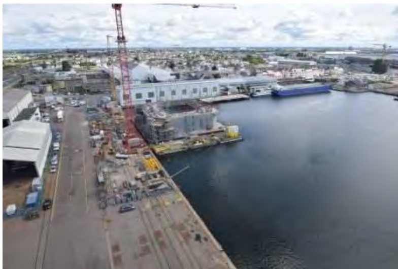
Le chantier de construction du pilote Floatgen à Saint-Nazaire fin juin. © Floatgen
